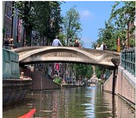
جسر ستوفبروج [هولندا] في أمستردام، أول جسر معدني مطبوع بتقنية الطباعة ثلاثية الأبعاد.
